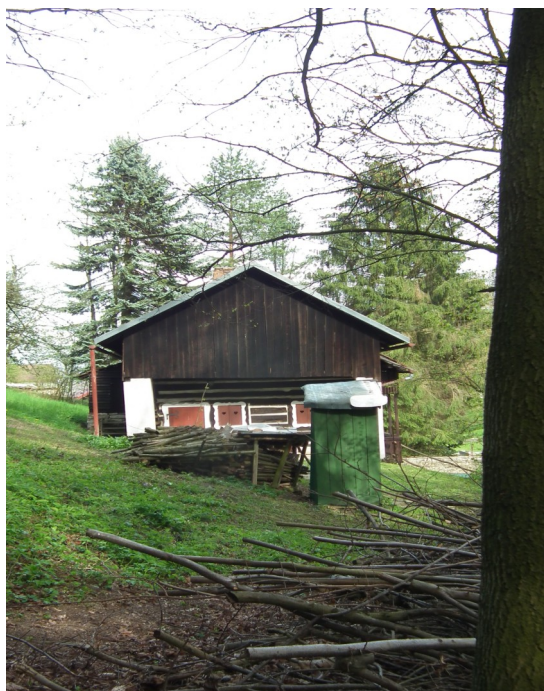
Obr.č.1 Čí je toto stavení?
